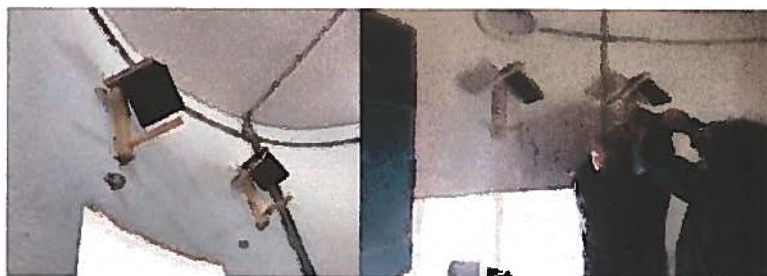
Fotografia 1 - última intervenção no pombal – Colocação de poeiros no piso intermédio (5/4/2018)
